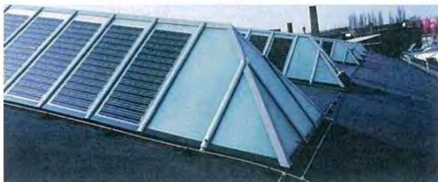
Figure 4.26 : Aréna à Berlin, Allemagne-toiture en dents de scie - chaud; modules verre isolant – source : Saint-Gobain
