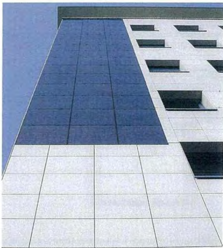
Figure 4.13 : Façade ventilée, écran pare-pluie ; Source : 3S.
