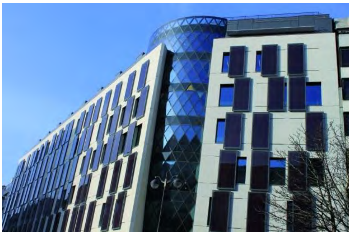
Figure 4.2 : La façade est dotée de volets coulissants motorisés en panneaux photovoltaïques. Élément fort du projet, source : Eurosic2011.
