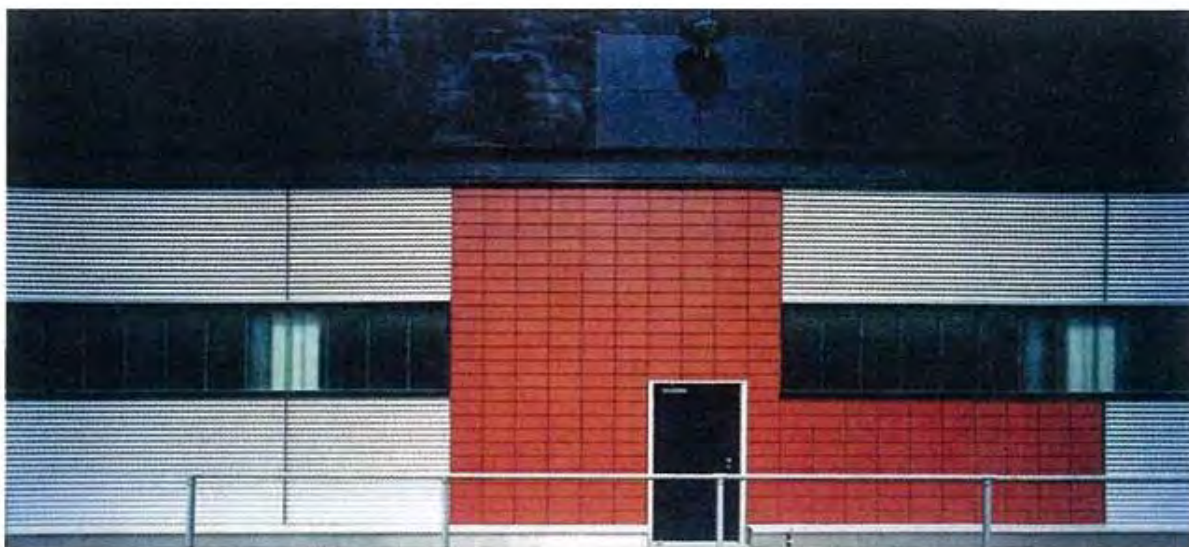
Figure 4.10 : la société Ostra transport public à Hanovre, Allemagne: Source: Solon AG, Gerhard
