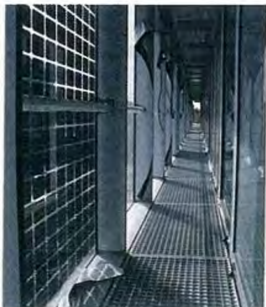
Figure 4.8 : Reconditionnement d'une façade en appliquant une double peau. Source: Solar Scheuten.
