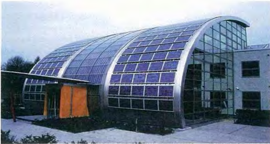
Figure 4.15 : Shell usine solaire de Gelsenkirchen, en Allemagne: - Scheuten Solar; système de fixation: Conergy: Les modules ont été montés sur les flasques de la toiture en métal avec des pinces spéciales. Source : Kalzip.
