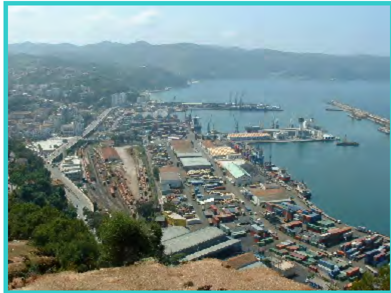
Photo n °01 : port de SKIKDA (prise le : 11/05/04)
