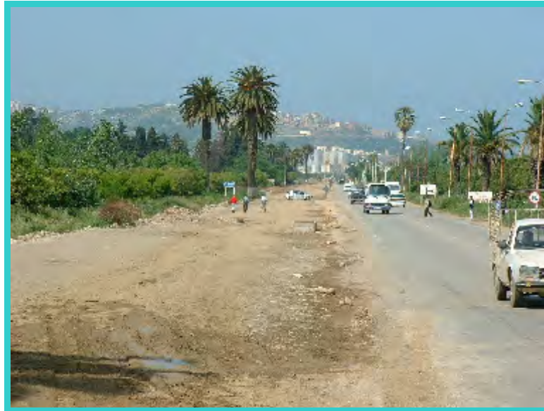
Photo n°38 ; l'axe routier la RN 03 Skikda El hadeik, on assiste a l'élargissement de la route au détriment du champs d'agrumes (prise le11/05/04)
