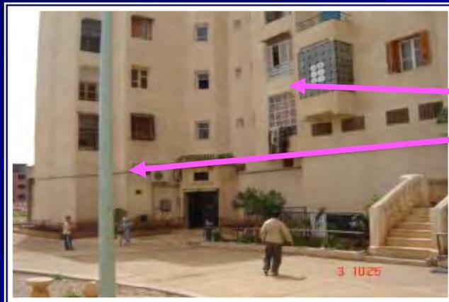
∅ Le problème d'étanchéité et d'insécurité obligent les habitants à fermer les séchoirs et balcons en plus des ouvertures.
