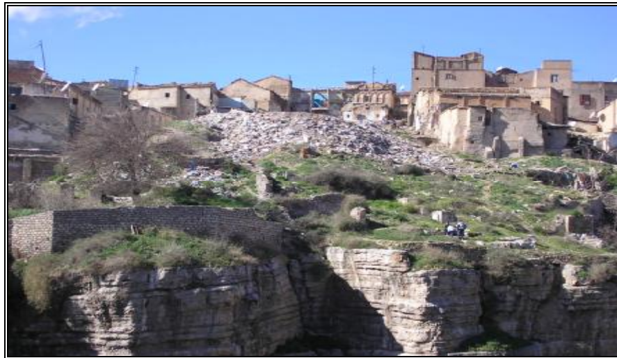
Photo n° 11 : Talus à accès difficile
