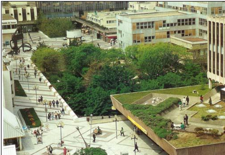
Figure n° 10 : La terrasse de l'agora 60
