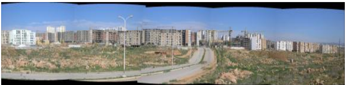
Photo n°15: La façade depuis l'hôpital militaire, une ampliation de bâtiments de bout en bout. Une volumétrie assez rigide.
