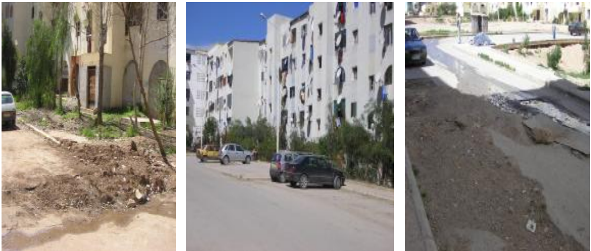
Photos n°46, 46' et 46'' : Malgré quelles soient réalisées récemment, nombreuses voies sont dans un état dégradé.
