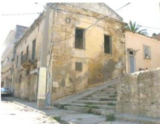
\*\*\* *Les constructions en mauvais état* : Cette catégorie est la plus marquante dans le périmètre d'étude. Ce sont généralement des constructions anciennes avec des fissures profondes sur les murs. 236 constructions (sur un total de 624) sont proposées à la démolition, soit 37,8 % de l'ensemble bâti.
