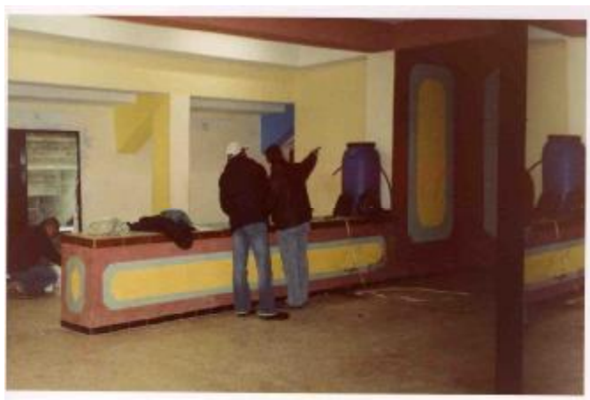
Figure 9.3: Vues sur le hall d'entrée principal et l'accès secondaire (administration et tribune officielle)
