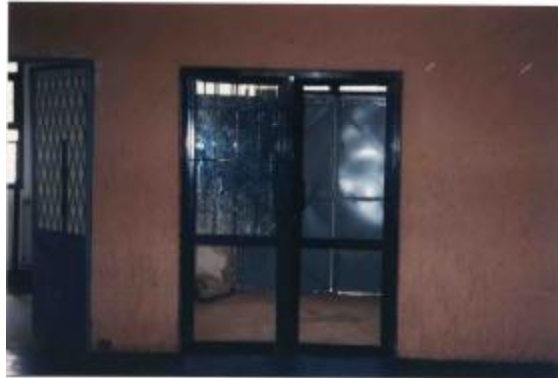
Figure 9.6 : Vue sur l'accès à la salle de compétitions
