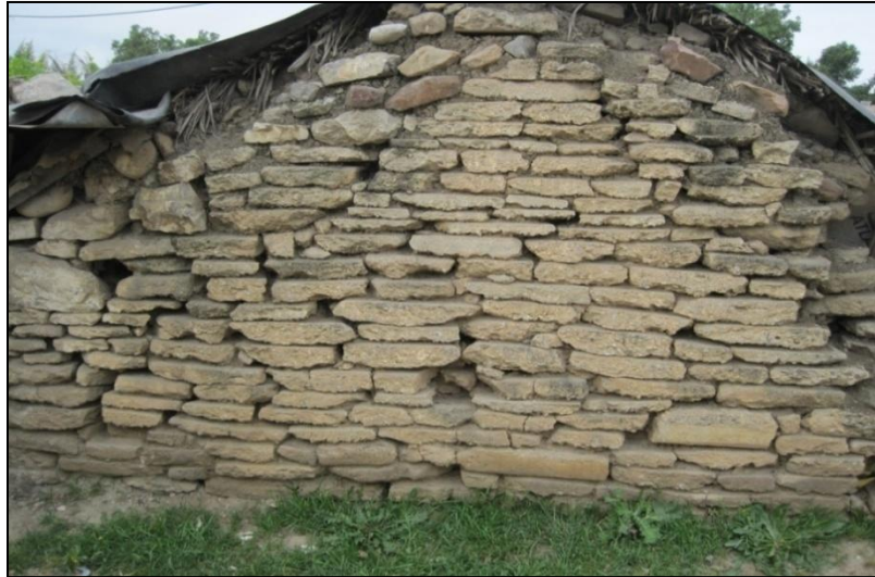
Figure 22 : Premier site d'échantillonnage au sein de la localité de Zighoud Youcef (Photo originale).
