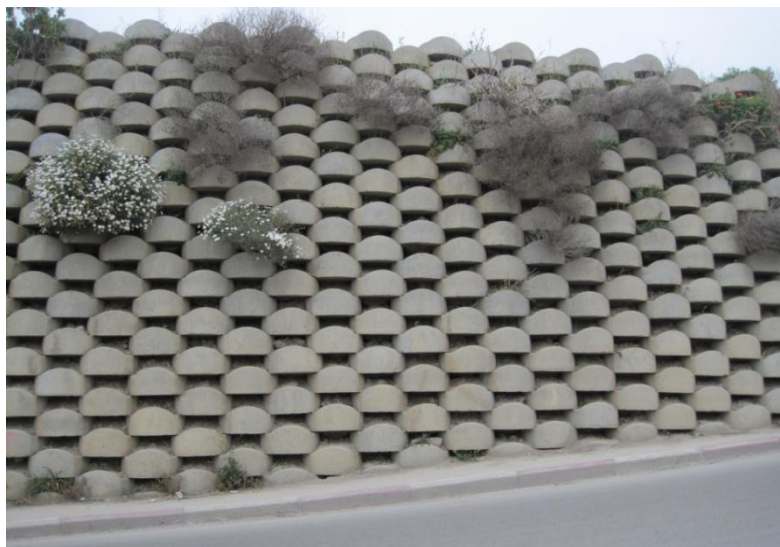
Figure 16: Premier site d'échantillonnage au sein de la localité de Didouche Mourad (Photo originale).
