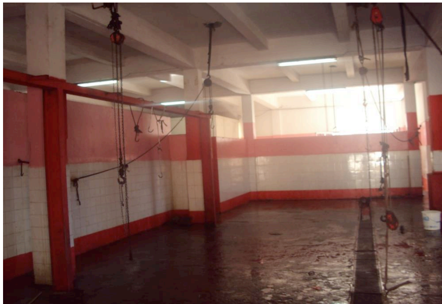
Figure 28: L'organisation des treuils de soulèvement dans la salle d'abattage (Photo personnelle)
