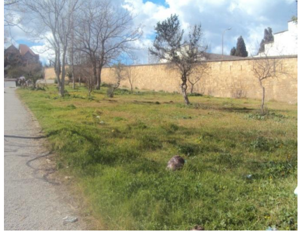
الصورة أ : الجدار الجنوبي لسور الثكنة .
