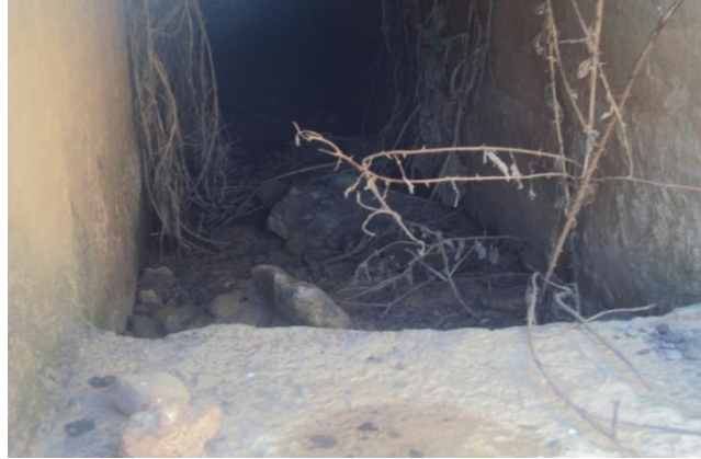
الصورة ج : منبع المياه .
