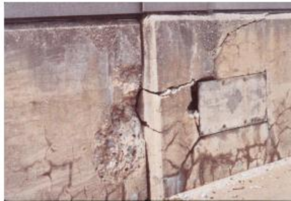
Figure I.9 : Exemple de différence de déplacement entre deux blocs voisins [Bouksani 2013]
