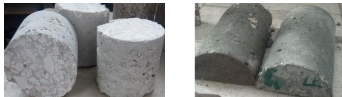
FigureV.3 : Les pièces de substrat avant de couler le béton de réparation.
