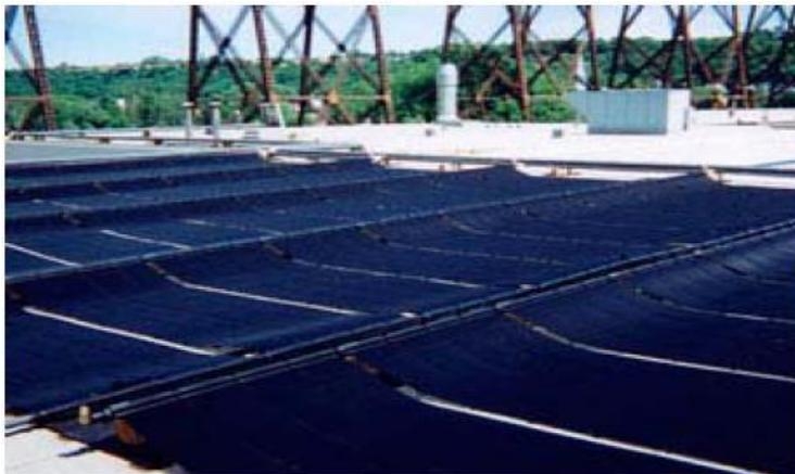
**Figure 7** : Capteur plan non vitré.
