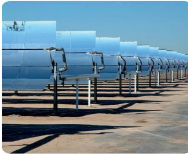
**Figure 4 :** Centrale à collecteurs cylindro-paraboliques.
