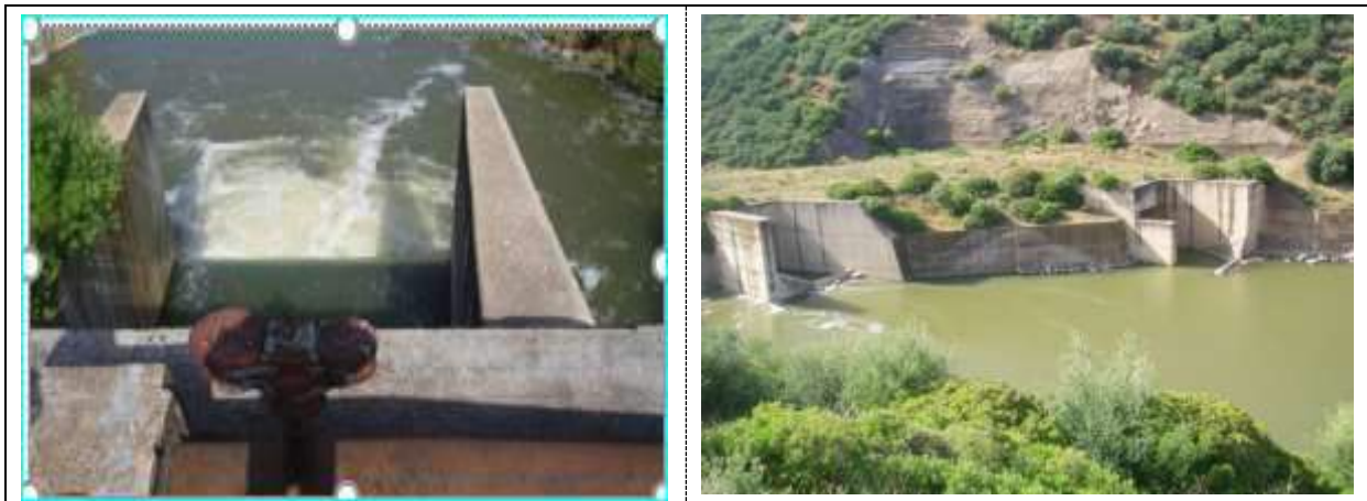
Photos n° 3 (a et b). Conduites d'eau de type « vannes jet en crue selon l'ANBT, 2006 », en contrebas de la digue du barrage de H. Debagh (vallée du Seybouse).
