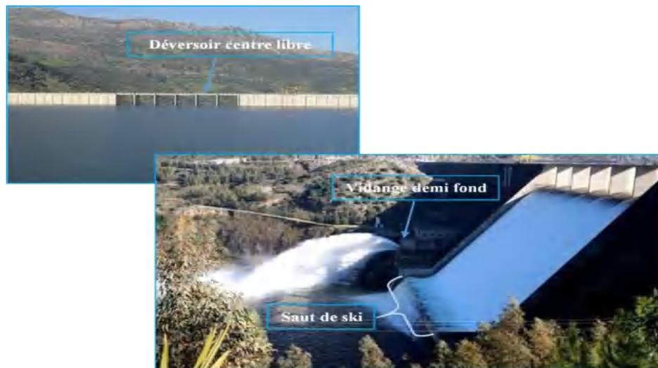
Photo 2: Evacuateur de crue du barrage de Beni Haroun: vue amont et vue aval (ANBT, 2014)
