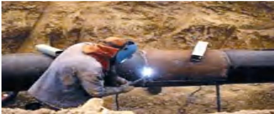
Figure I.47. Opération de soudage de la demi-coquille [96]
