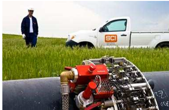
Figure IV.3 Inspection par ultrasons avancés [84]
