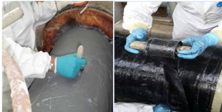
Figure IV.7 Banks Industrial Group, Revêtements protecteurs et réparation par composites époxy [96]
