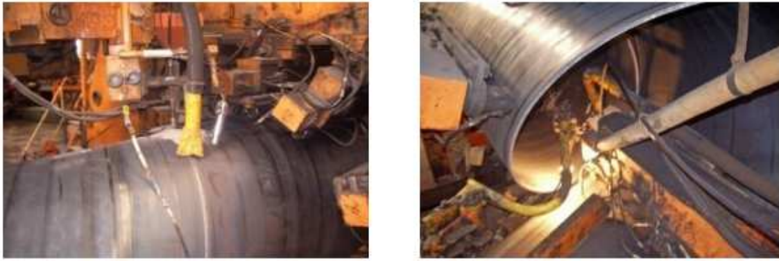
Figure I.5 Soudage d'un tube
