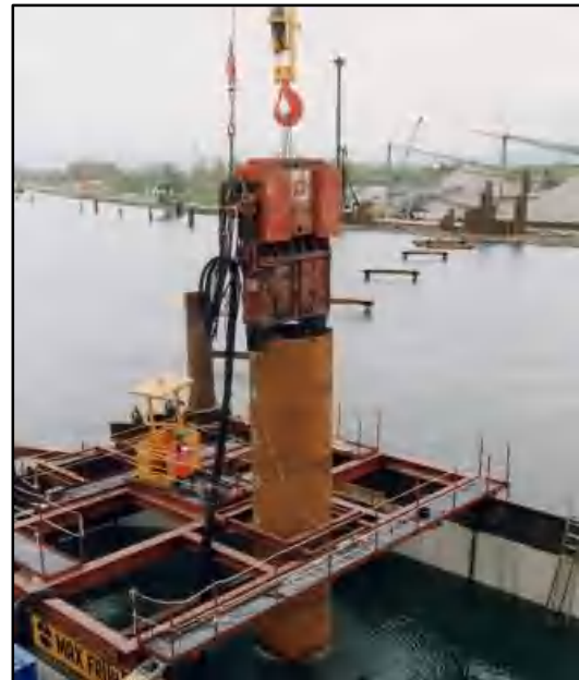
Figure II.10 Outils de vibrofonçage Pieux/H/palplanches battus [Classe : 4/5/6/7] [8]
