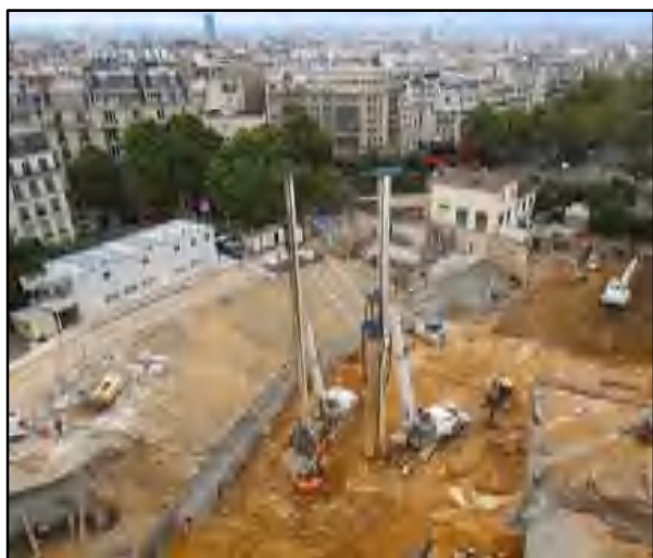
Figure II.8 Pieux forés tarière creuse [Classe : 2] [8]
