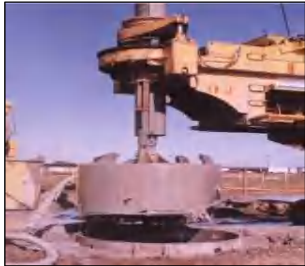
Figure II.6 Pieux forés boue [Classe : 1 ; Cat : 2] [8]
