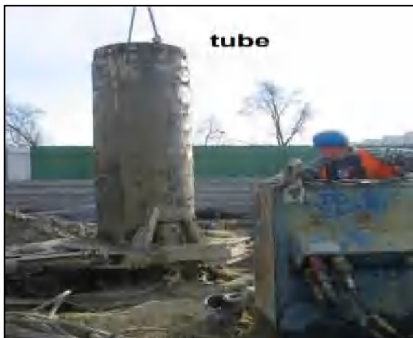
Figure II.7 Pieux forés tubés [Classe : 1 ; Cat : 3/4] [8]
